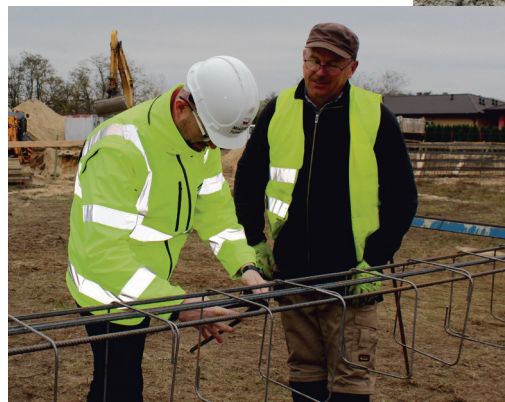
Burmistrz Romuald Antosik na budowie bloków wiązał strzemiona zbrojenia ław fundamentowych.
