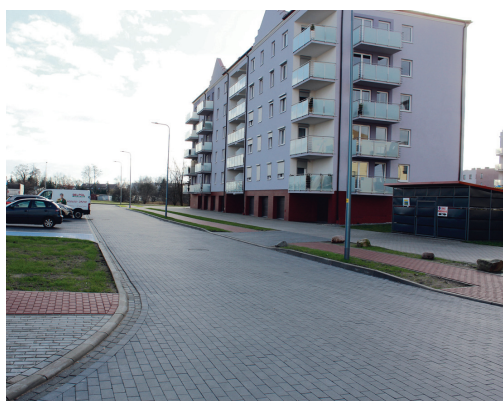
Nowa ulica na Os. Wyzwolenia, pomiędzy blokiem a przedszkolem.
