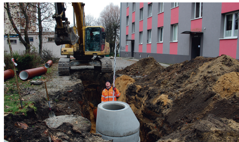
Droga w tym miejscu nigdy nie była utwardzona, co stwarzało problemy mieszkańcom.
