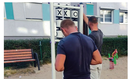
Nowe urządzenia zamontowano przy ul. Wyszyńskiego i ul. Górniczej.
