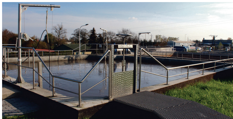
Po modernizacji oczyszczalnia spełnia wyższe normy oczyszczania ścieków i jest bardziej przyjazna dla środowiska.
