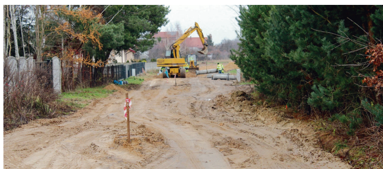
Prace przy budowie ulic osiedlowych na osiedlu Leśna.
